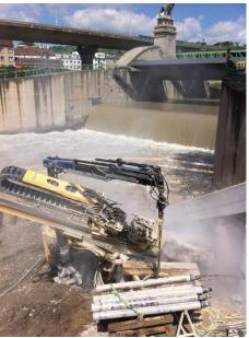
Im Auslaufbereich der Fischaufstiegshilfe befindet sich das Wendelbecken. Die wasserdichte Baugrube wurde mit einer aufgelösten Bohrpfahlwand mit DSV-Zwickelabdichtungen hergestellt. Die Bohrpfahlwand wurde mit Bauzeit- sowie Dauerankern gesichert.
