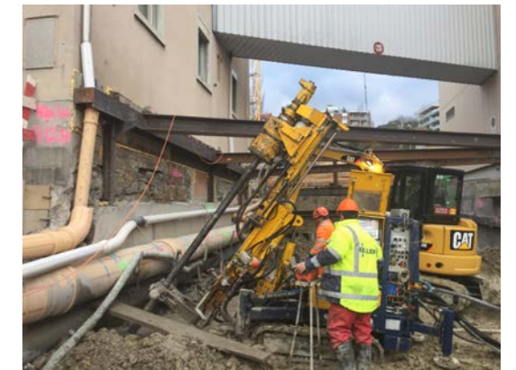
Herstellung der Unterfangung unter beengten Verhältnissen.
