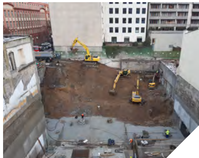
AUSHUB DER BAUGRUBE
