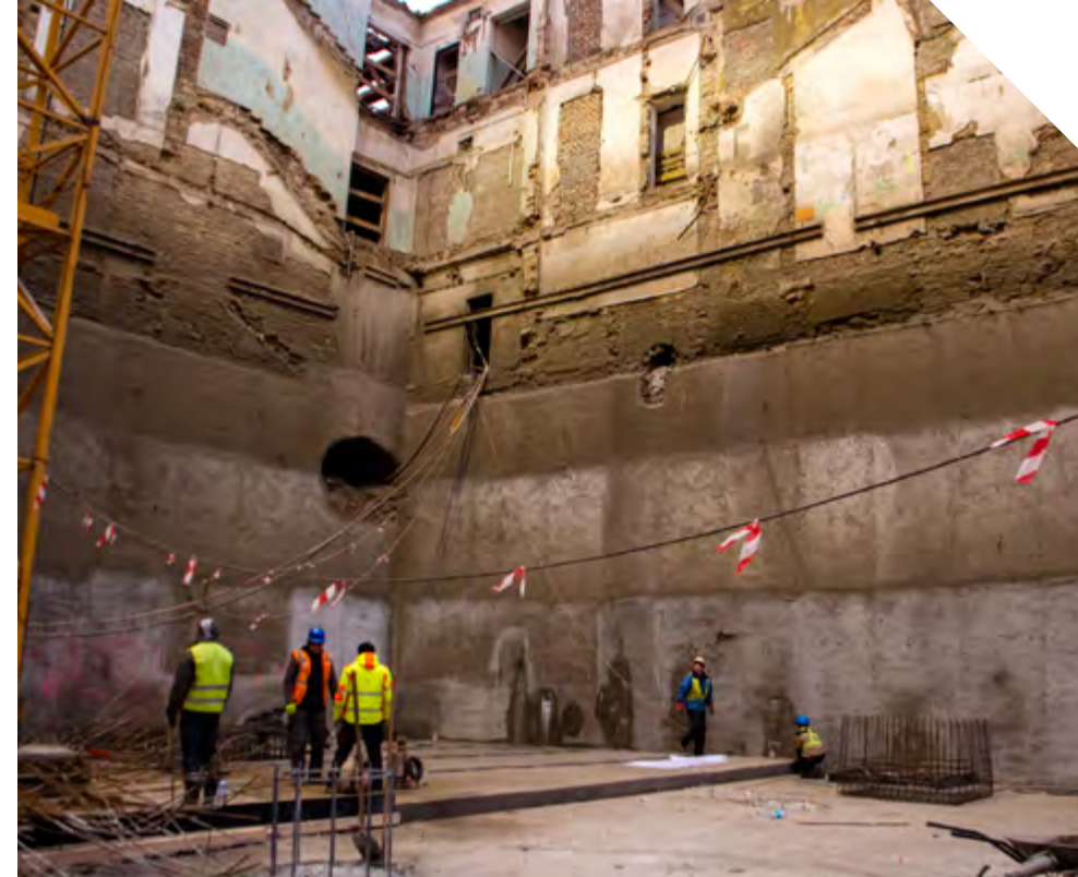
UNTERFANGUNG DER EXISTIERENDEN BAUOBJEKTE
