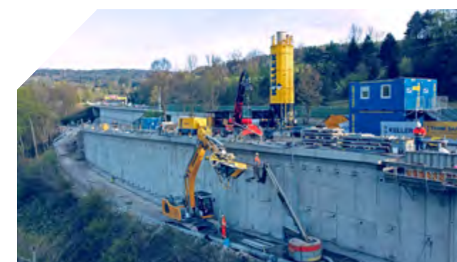
Schritt 1: Herstellung Vorsatzschale mit Ankerungen Schritt 2: Abbruch und Neubau Mauerkopf (Vorteil: Spur 200 kann länger mit größerer Breite genutzt werden)
