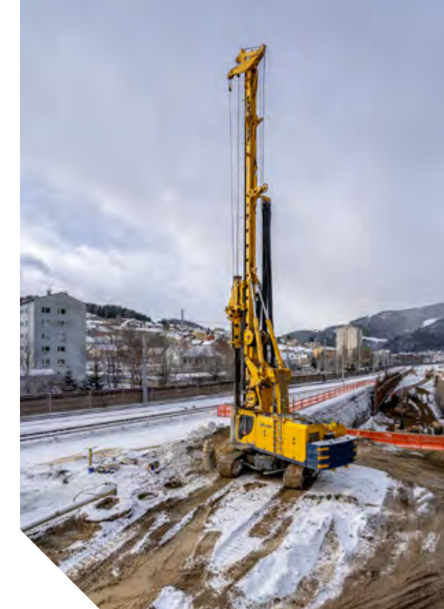
PORTAL: HERSTELLUNG BOHRPFÄHLE
