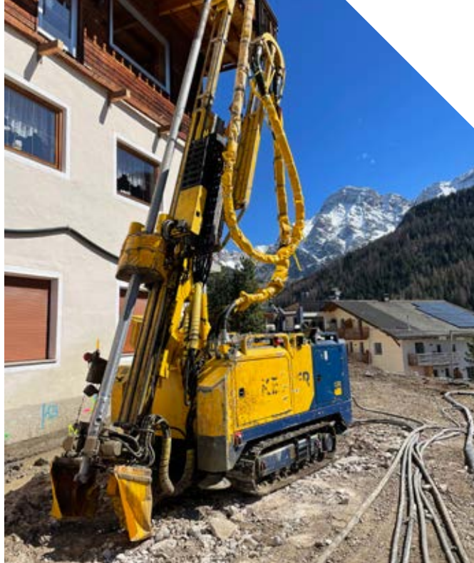
HOTELERWEITERUNG – UNTERFANGUNG MIT DSV Hotel Alpenrose – Wengen
