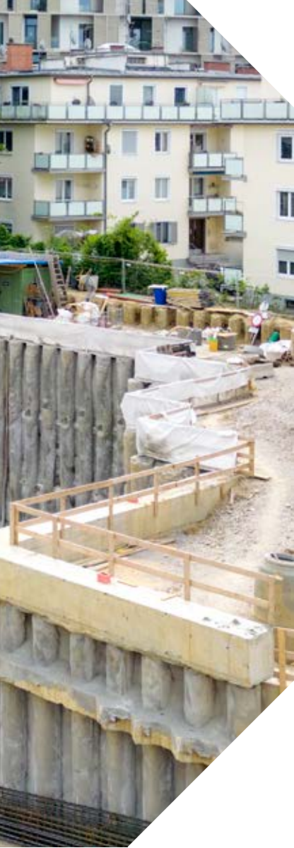
HERSTELLUNG DER PFÄHLE für Baugrubensicherung sowie Gründung im SOB-Verfahren
