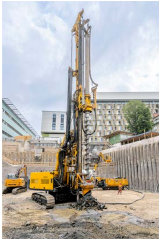
HERSTELLUNG DER PFÄHLE für Baugrubensicherung sowie Gründung im SOB-Verfahren
