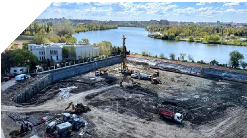
FOTO WÄHREND DER AUSFÜHRUNG DER GRÜNDUNGSPFÄHLE
