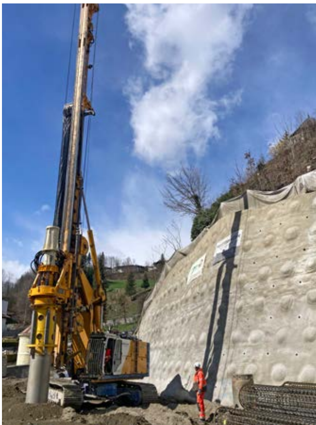
HERSTELLUNG DER GROSSBOHRPFÄHLE
