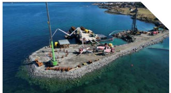
BETONIEREN DER ACHSE 4 UND BOHRARBEITEN AUF ACHSE 3
