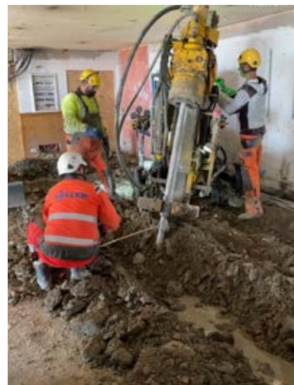
HOTELERWEITERUNG IN „TOP DOWN“ Hotel Huber – Vals
